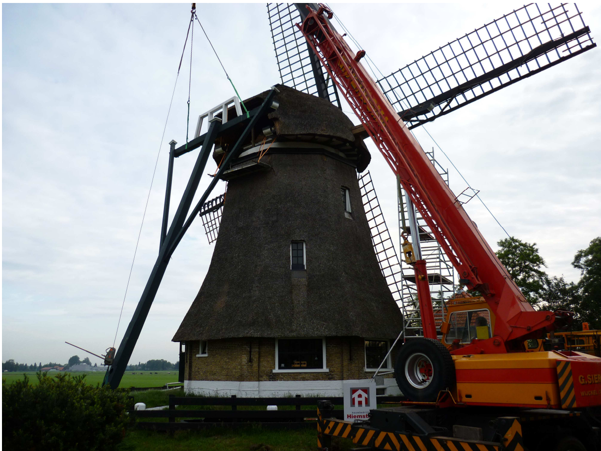
Foto genomen tijdens de hijswerkzaamheden van de staartconstructie
