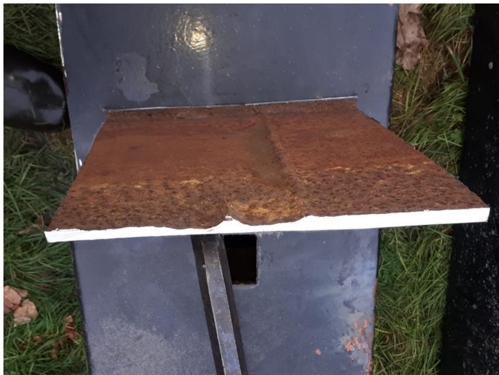
Detail van een deel van de roede waarbij geen dikteverlies waarneembaar is en een deugdelijke stuiknaad aanwezig is.
