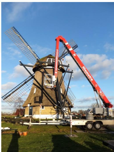
Het plaatsen van de generator.
